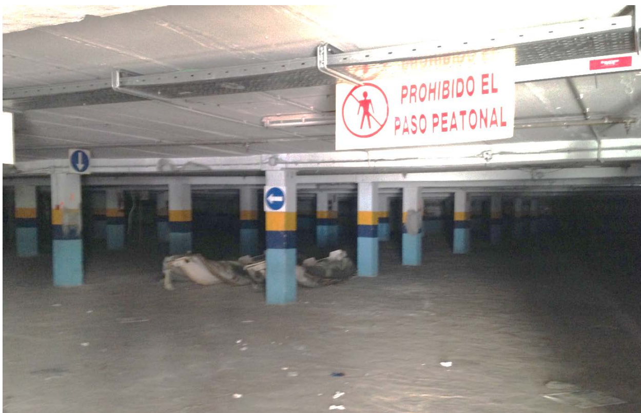
Aspecto del sótano 1 de aparcamiento.
