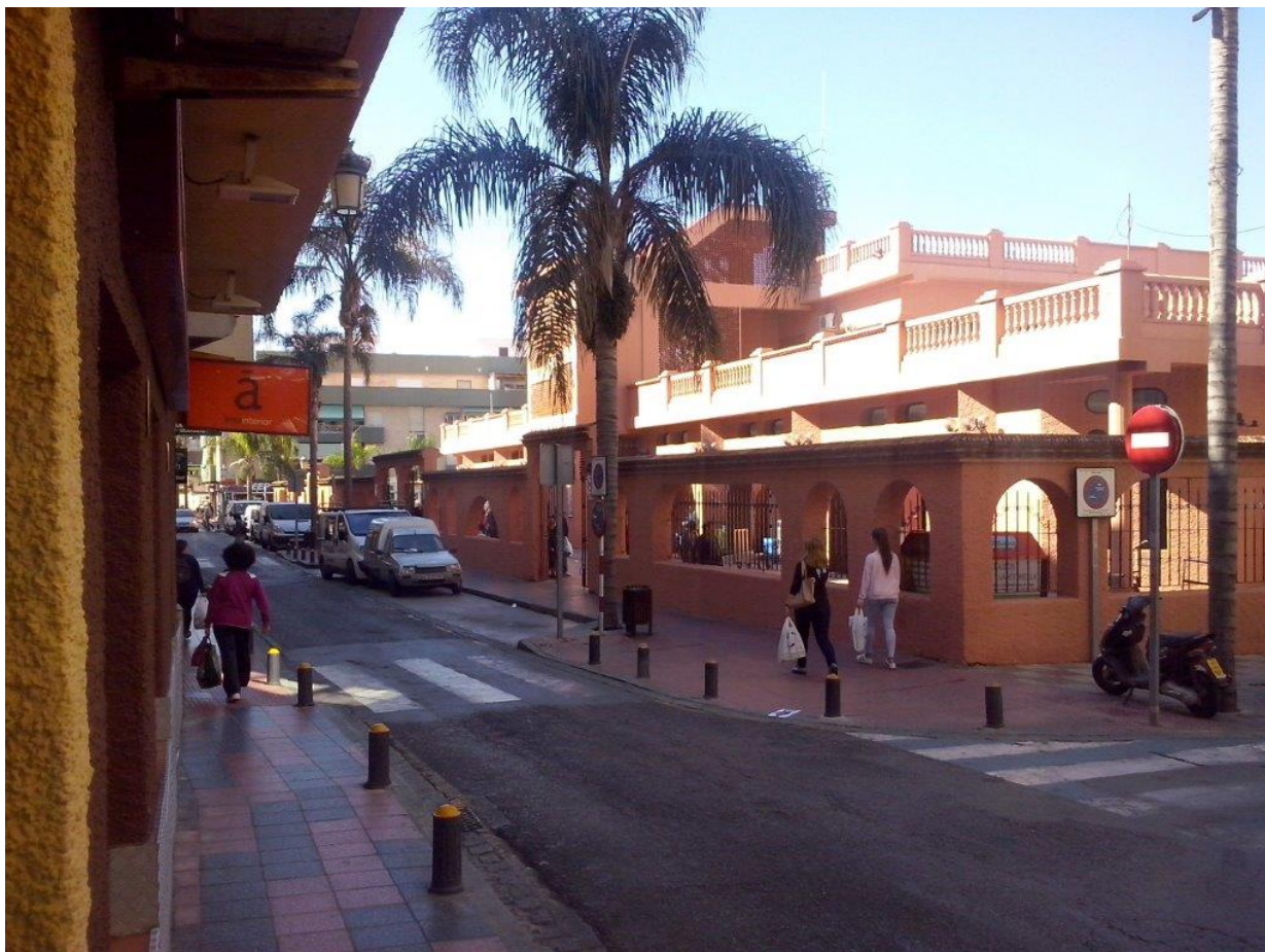
Fachada principal desde Avenida. de Cala.
