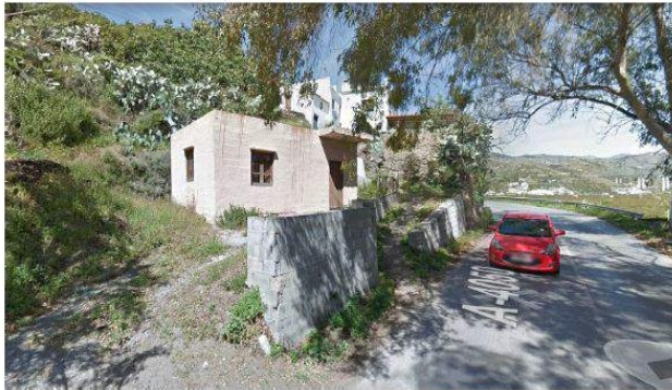
Situación actual donde puede apreciarse la pequeña edificación en la zona sur de la parcela. Las infraestructuras urbanas son equivalentes a las de las fincas colindantes. Se carece de acerado y alumbrado público.
