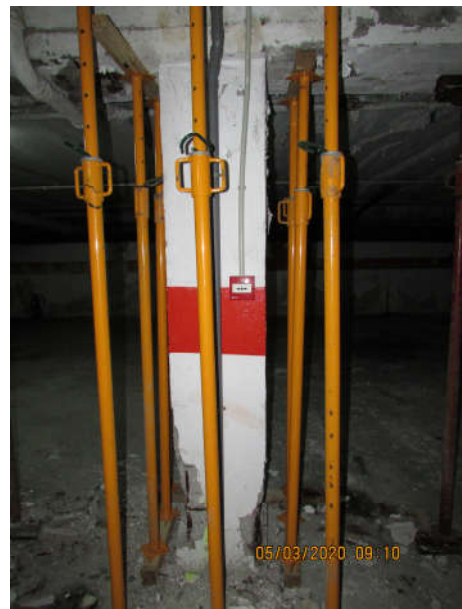
Soportes de planta -1 bajo puestos de pescado con pérdidas de sección en cabezas y arranque en zona con patologías más severas.
