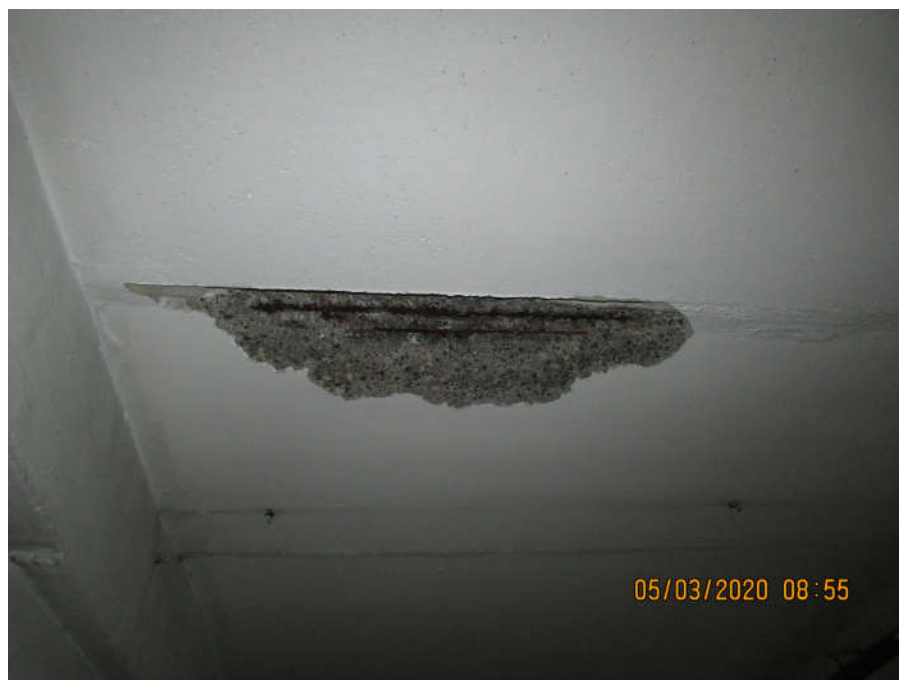
Afecciones sobre las placas alveolares del forjado de techo de planta sótano -1.
