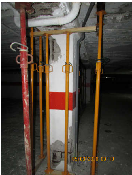
Soportes de planta -1 bajo puestos de pescado con pérdidas de sección en cabezas y arranque en zona con patologías más severas.
