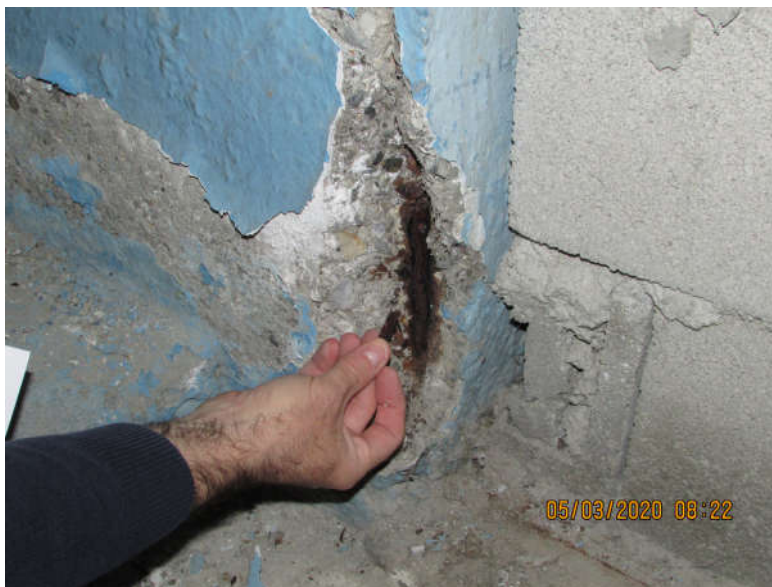
Afección en base del pilar junto al acceso de garaje por calle Sánchez Chaves.
