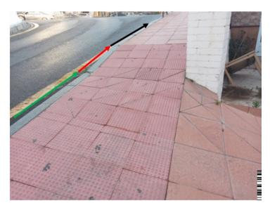
Dicha pendiente del acerado está condicionada por la propia orografía de la zona, ya que el vial va ascendiendo en sentido salida con una pendiente media del 12%, por los accesos de las casas y vado de salida de vehículos existente. Como se puede apreciar en las fotografías siguientes. El pavimento en la zona pública coincidente con el vado de entrada/salida de vehículos, y con la zona de rampa de mayor pendiente, es de tipo baldosa de punta de diamante, antideslizante y táctil.
