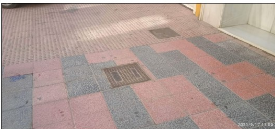
Foto 2. Arqueta de alumbrado público objeto del informe.
