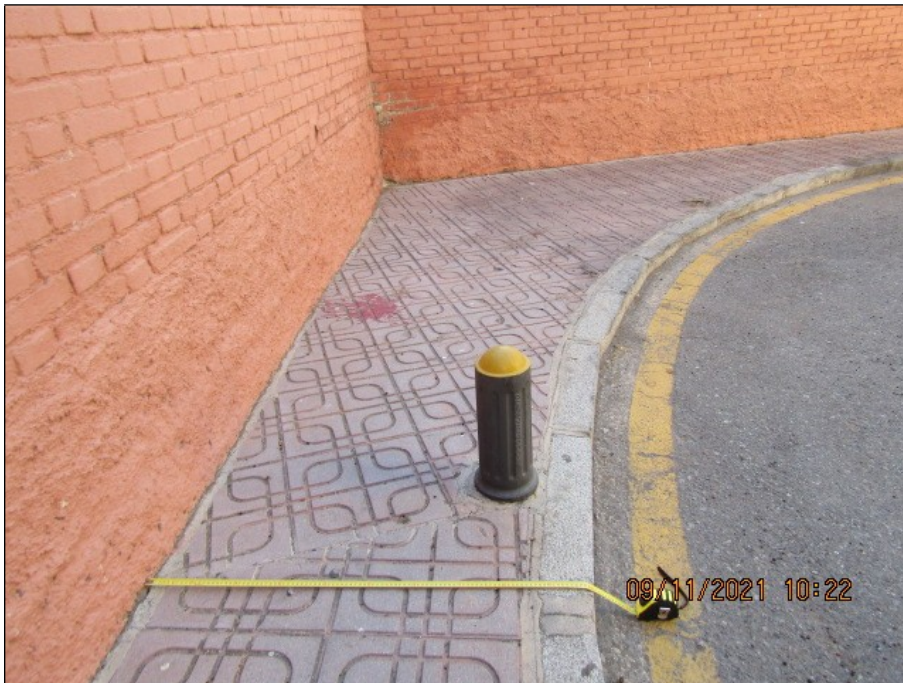
Foto 3. Medición del ancho estricto del acerado
