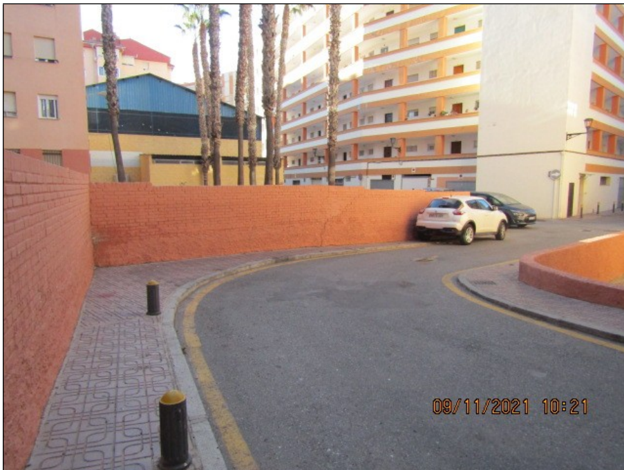
Foto 2. Calle Horno Pan Cocer. Acerado delimitado con bolardo para evitar el aparcamiento sobre el acerado. Se puede observar como en aquellas zonas donde no existen bolardos, los vehículos estacionan sobre el acerado.
