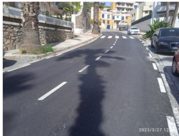
Ilustración 1 y 2. Estado actual de la vía
