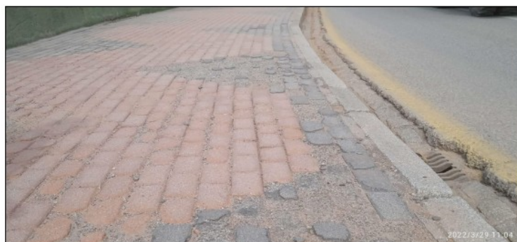
Foto2. Vista localizada de la zona indicada por la interesada, desde acerado hacia el Oeste
