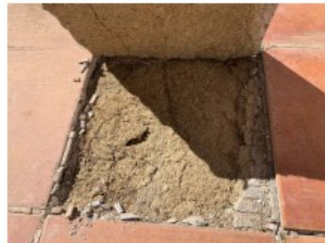
Se levantan las baldosas y se observan raíces bajo la solería
