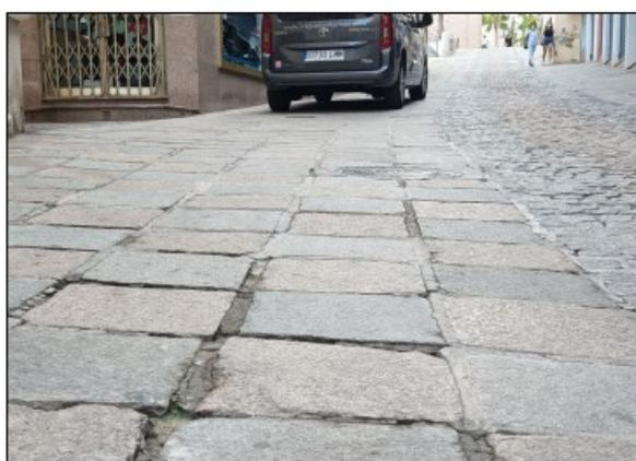
**Foto 4.** Pérdida de cemento en las juntas del pavimento de baldosas de granito. Zona donde ya actuaron los Servicios de Mantenimiento, y que comienza a dar síntomas de fallo.
