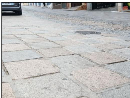
**Foto2.** Pavimento de baldosas de la vía, bajo la tapa de registro donde se produce la caída.
