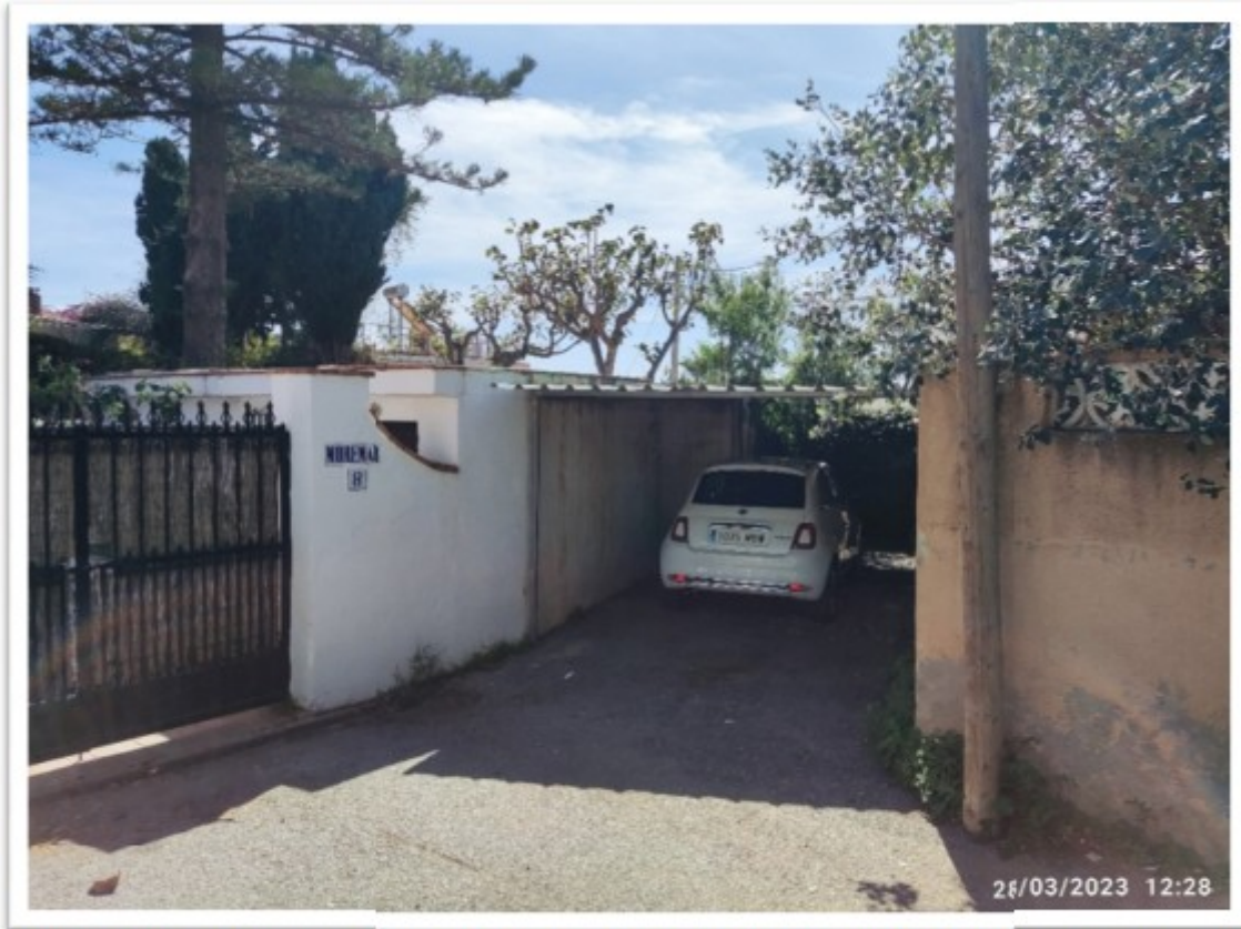
Vista de la zona ocupada exterior a la valla de cerramiento de la parcela 0973010VF4607D0001XW. Fotografía de los Servicios Técnicos de Inspección de 28 de marzo de 2023.
