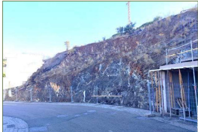
7-Roca esquisto cuarcítica con buzamiento externo y meteorización baja tipo II
