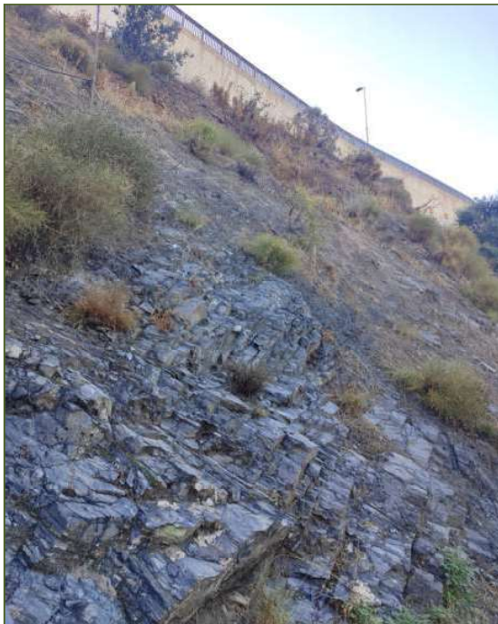
Roca esquisto buzamiento exterior y betas de cuarzo
