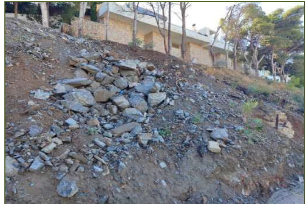
12-Rellenos en la parte más alta de la parcela junto carretera
