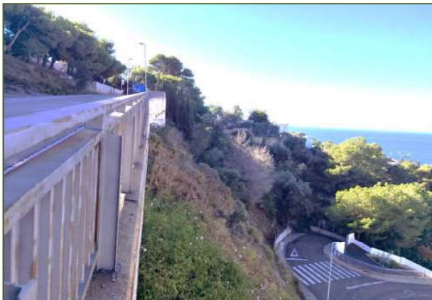
12-Muro superior sobre talud
