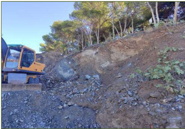
11-Rellenos en la parte más alta de la parcela junto carretera
