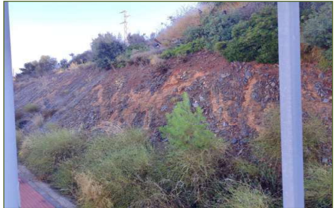
8-Roca esquisto cuarcítica con buzamiento externo y meteorización baja tipo II
