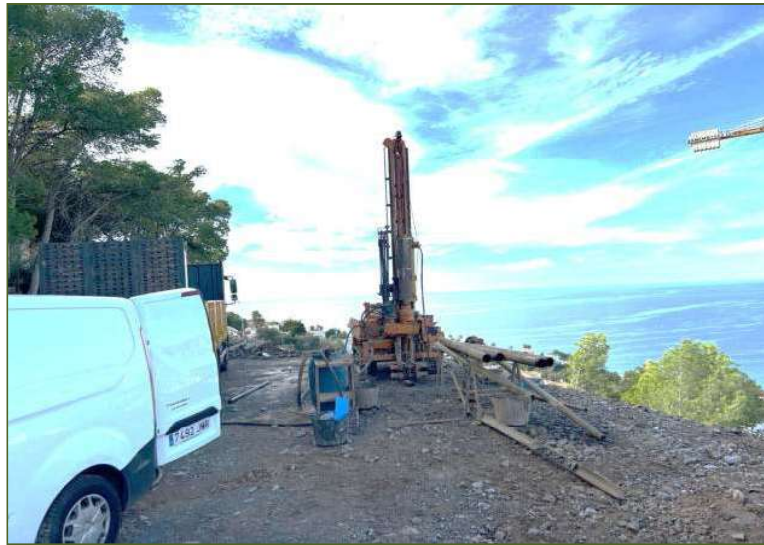
Registro de realización de sondeo 1
