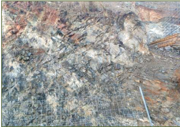
7-Roca esquisto cuarcítica con buzamiento externo y meteorización baja tipo II
