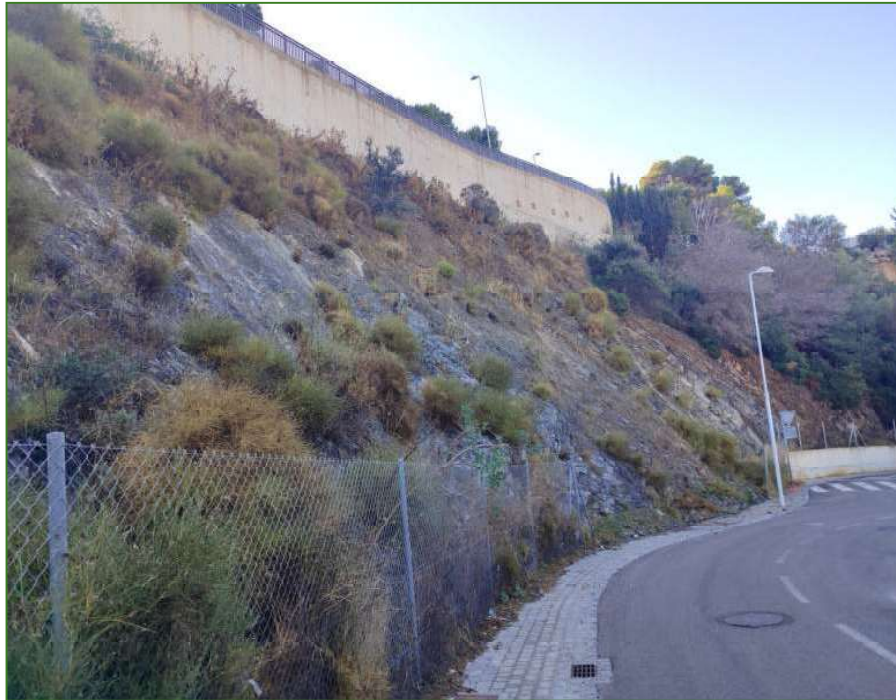
Zona con muro a cabecera de talud y elevada pendiente
