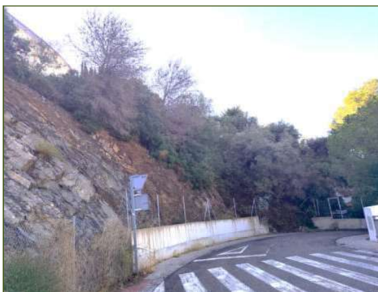
6-Roca esquisto cuarcítica con buzamiento externo y meteorización baja tipo II
