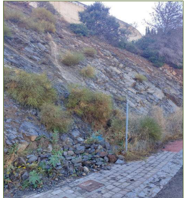
Roca esquisto buzamiento exterior y betas de cuarzo
