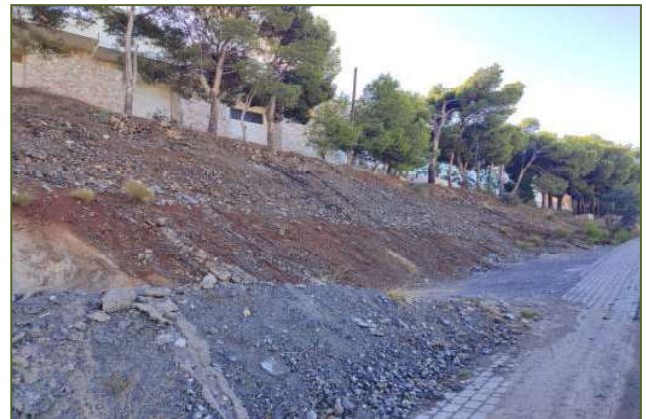
10-Roca esquisto betas de cuarzo y relleno de arena y meteorización baja tipo II-III
