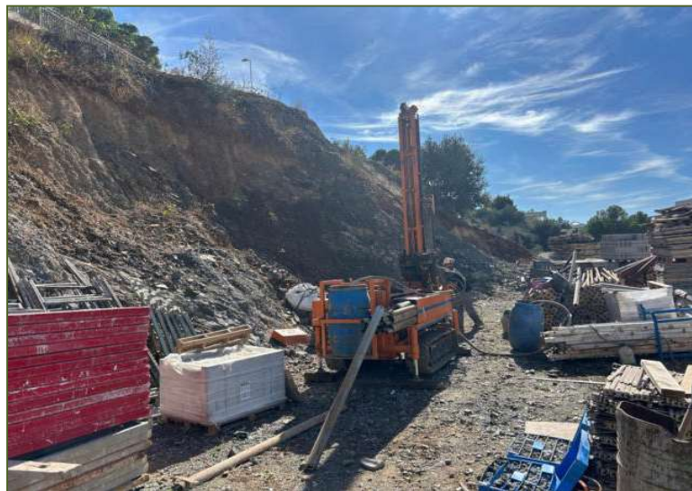
Registro de realizacion de sondeo 2
